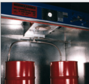
Fass Absauganschluss (mit Vakuum) Drum extraction connectors for vacuum
